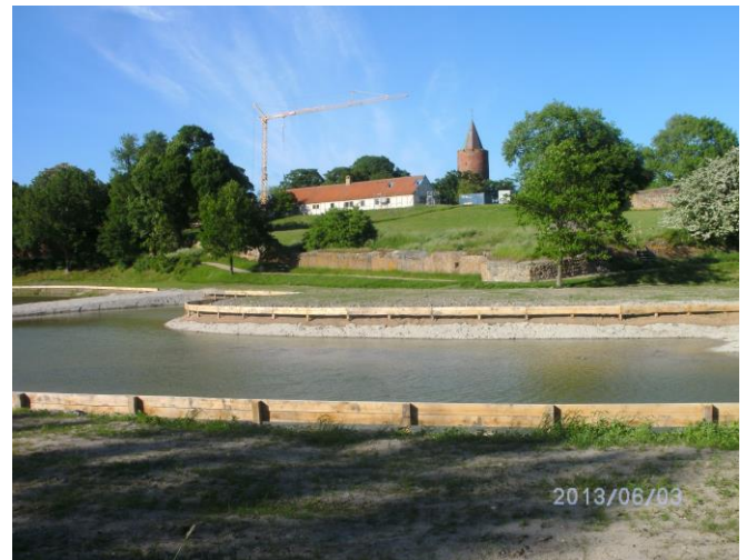
Voldgraven under opbygning
